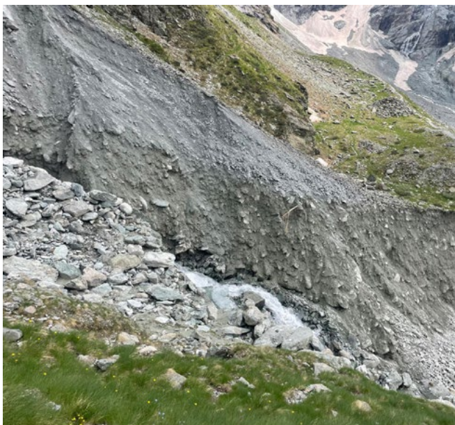
Le Torrent de Bertol après les intempéries du 20 juin
