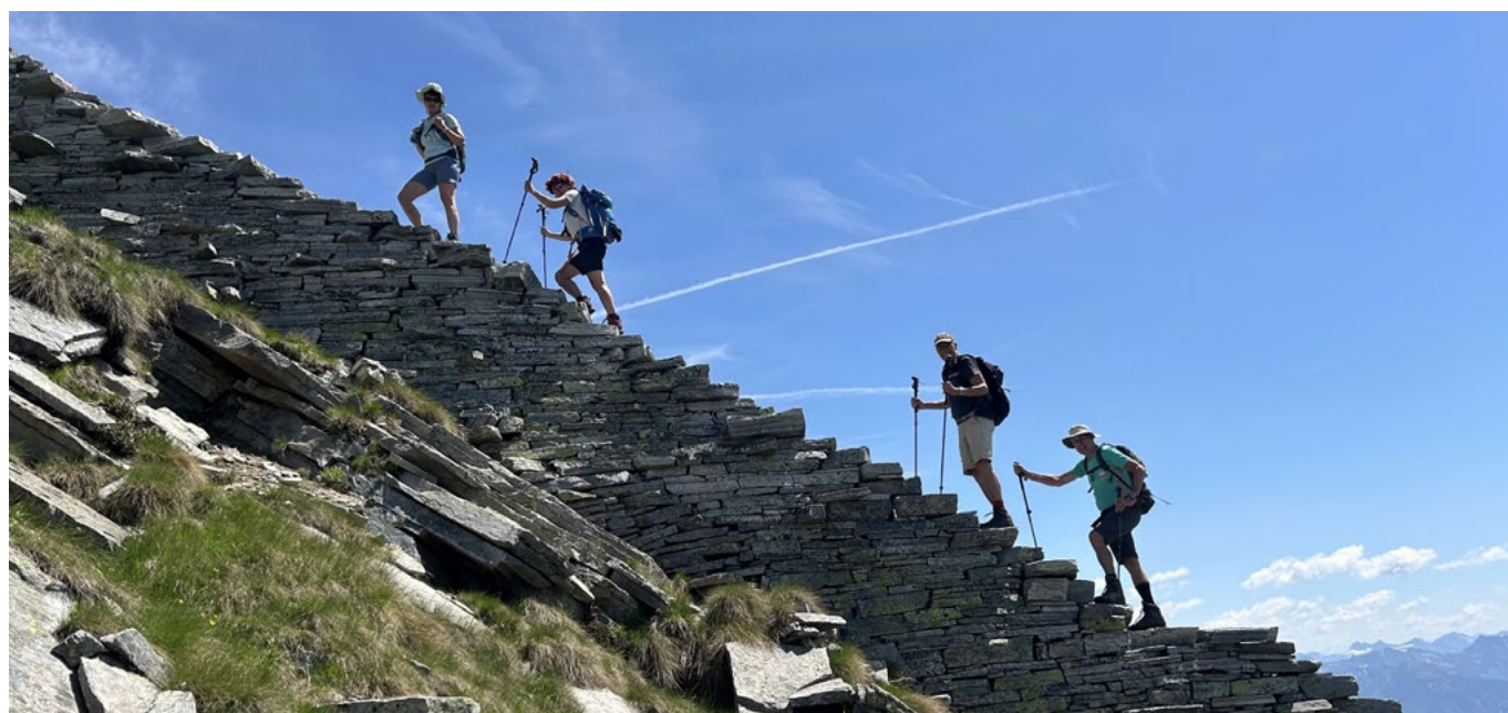
Le «mur du Bombögn», long de 300 mètres et haut de 2.20 mètres, construit sur une pente à 60% pour contenir les chèvres et les empêcher de venir manger de jeunes arbres fraîchement plantés
